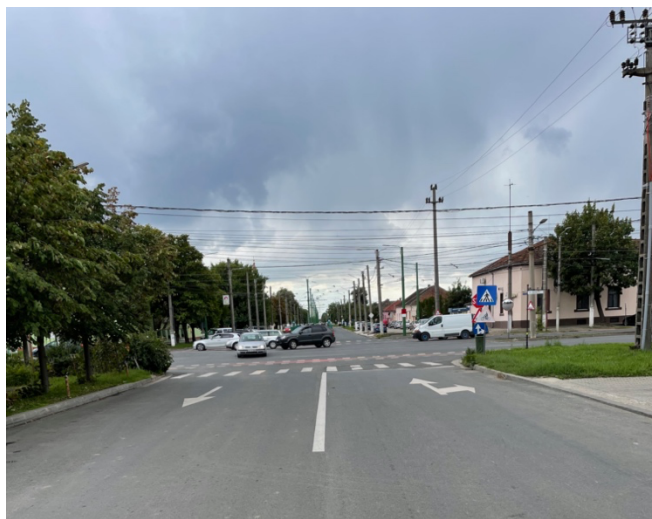
str. Prutului -vedere spre sud
